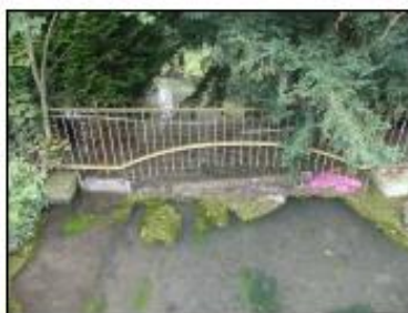
Figure 21 : Ligne 325 000 - Vue aval du cours d'eau (présence d'une barrière et de déchets dans le lit mineur)
