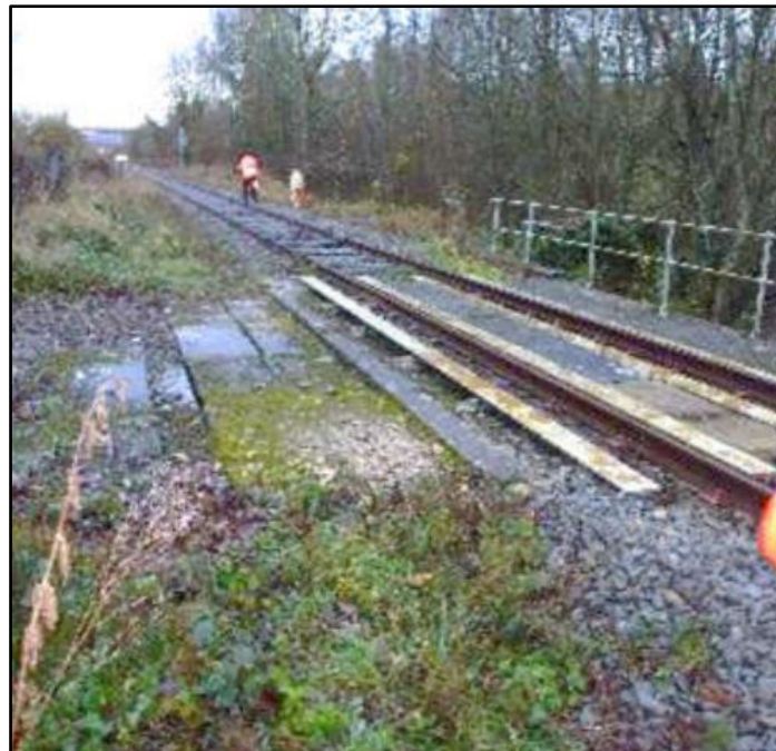
Figure 2 : Ligne 325 000 - Vue du dessus de l'ouvrage au Pk 136+974
