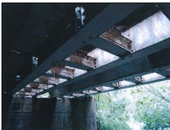
Figure 7 : Ligne 325 000 - Etat actuel de l'ouvrage - Intrados du tablier en service existant
