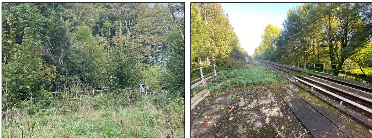
Figure 6 : Ligne 325 000 – Photographie de l'ouvrage au Pk 136+974
